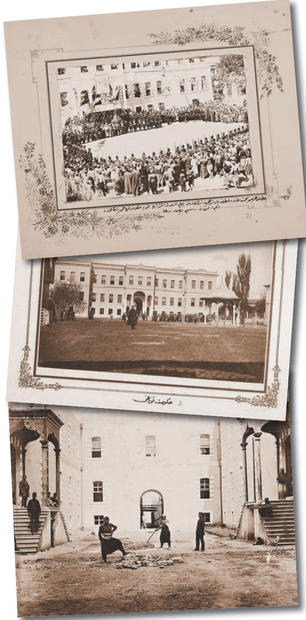
Konya Hükümet Konağı
