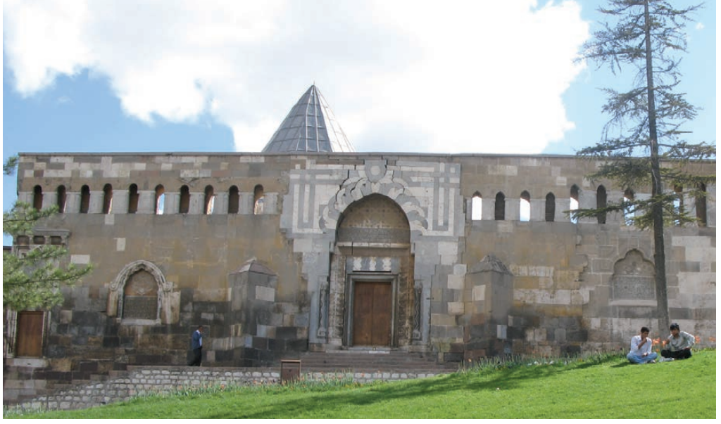
Caminin kuzey (avlu) cephesi
